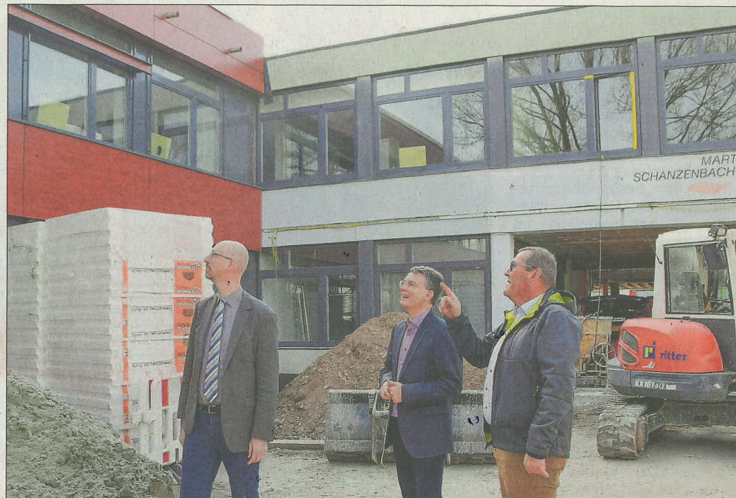
Zeigten sich beeindruckt vom Fortgang der Gymnasiums-Sanierung (von links): Schulleiter Stefan Feld, Bürgermeister Thorsten Erny und Bauamtsleiter Helmut Kälble.
